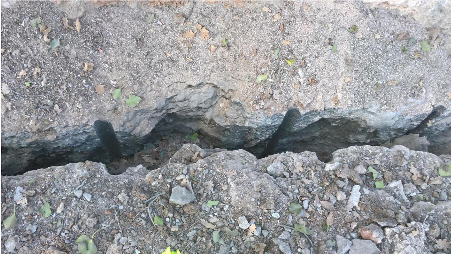
Successivamente al taglio con presplitting, le volate di produzione sono state tutte monitorate tramite l'installazione di sismografi presso le abitazioni adiacenti.
