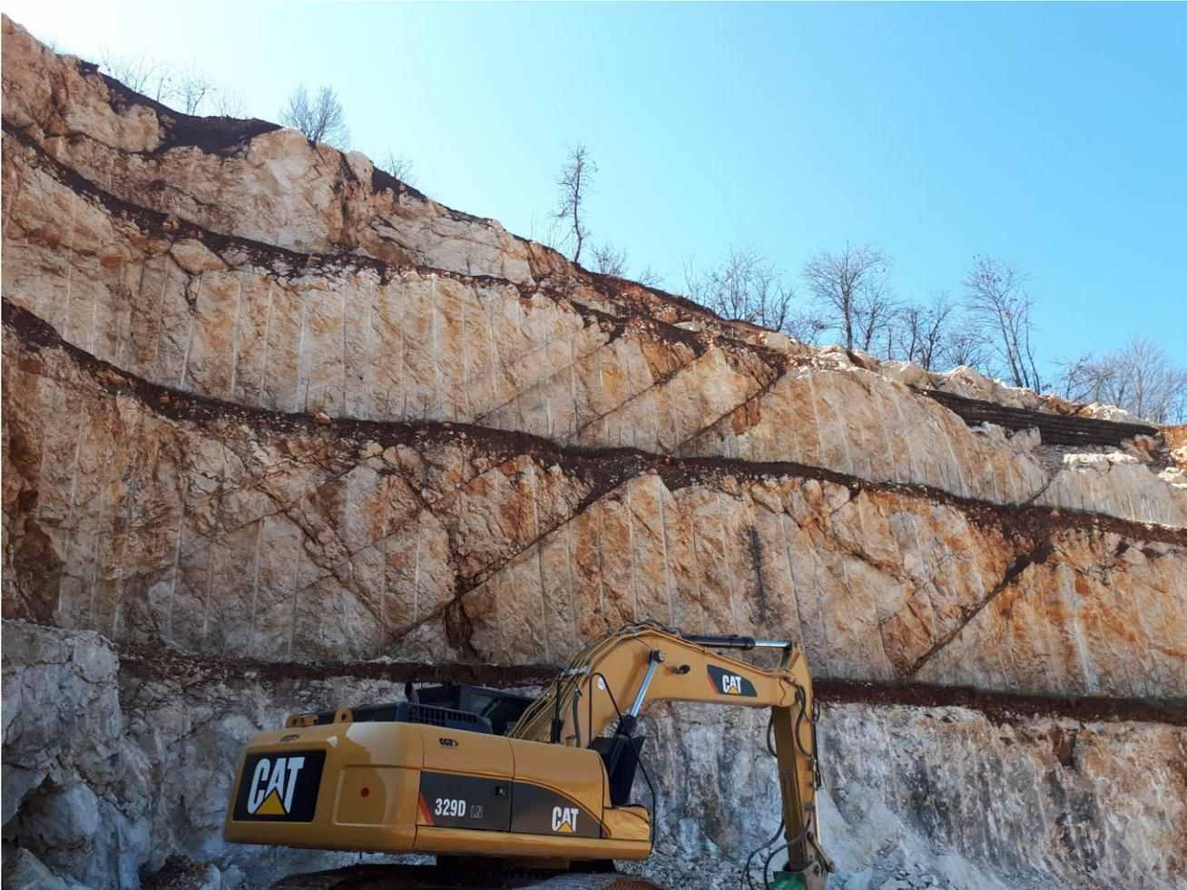
In questo caso il Presplitting viene realizzato su fronti di 8-10 m con fori diam. 64 mm e distanti circa 1,0 m tra loro, caricati con un cordone di Riocord 100 e una cartuccia di dinamite Riodin HE diam. 50 mm al piede.
