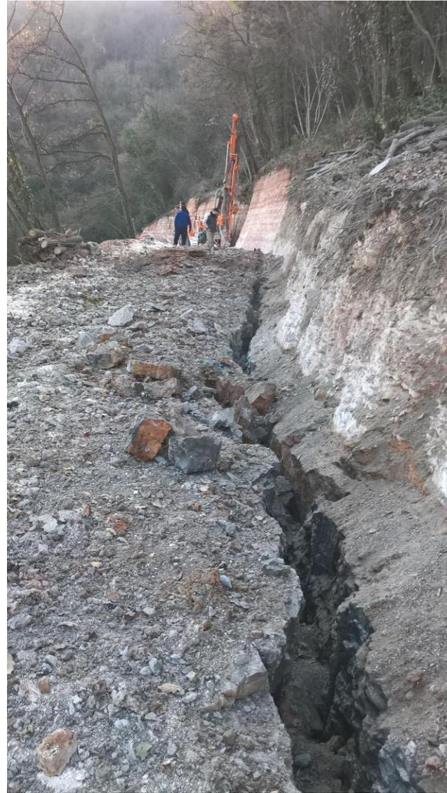
Nel progetto delle volate di Presplitting si è dovuto tener conto della vicinanza ad alcune abitazioni ( $\approx 290\text{m}$ ), per cui si è preferito utilizzare come carica al piede una cartuccia di Riodin HE diam. 40 mm (diam foro 76 mm).
