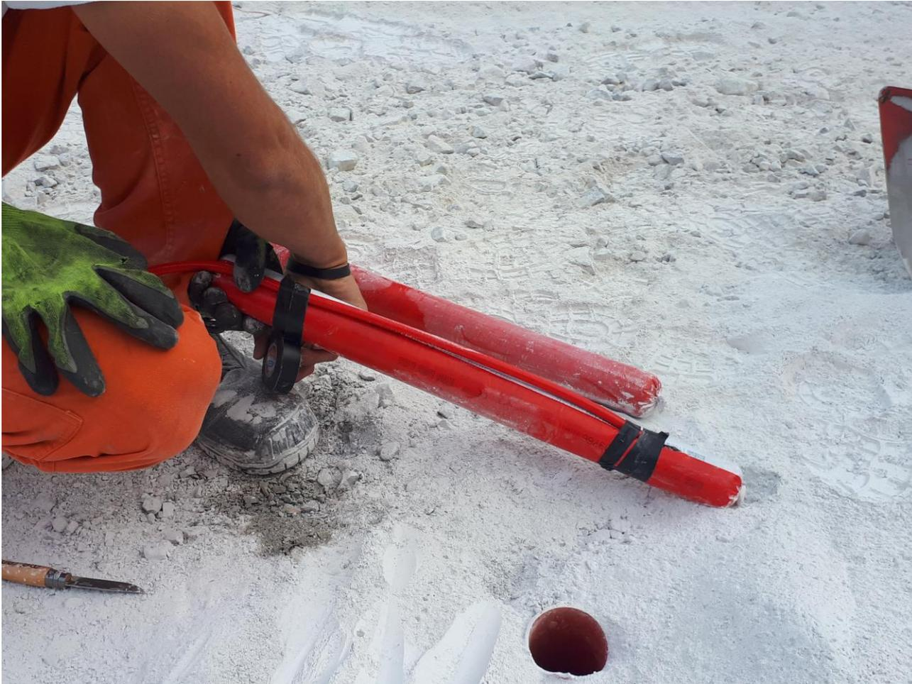
Il presplitting viene realizzato mediante l'utilizzo di miccia detonante Riocord 100 accoppiata a 2 cartucce di un'emulsione molto energetica denominata «RIOHIT XE».
