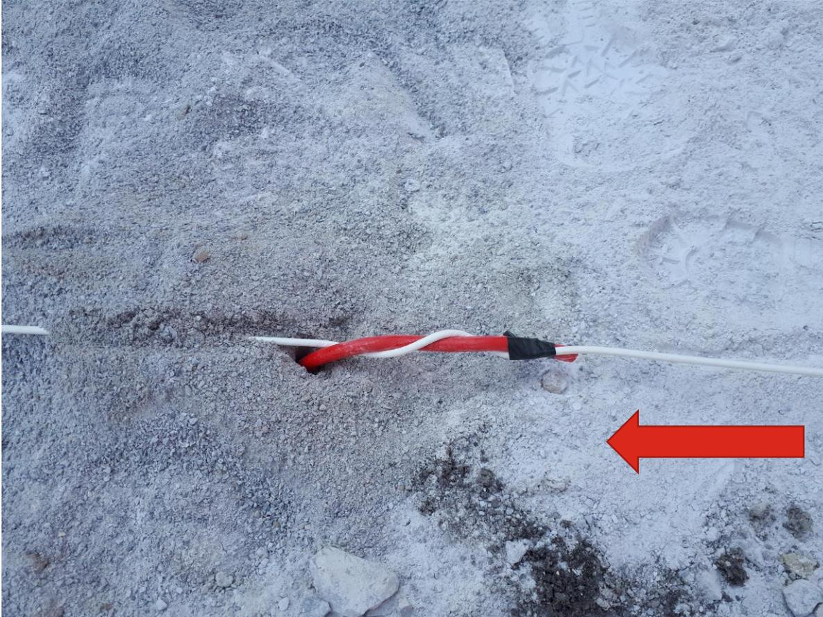
**Il collegamento finale viene realizzato con miccia detonante Riocord 20, normalmente utilizzata nel caricamento dei fori di produzione.**
