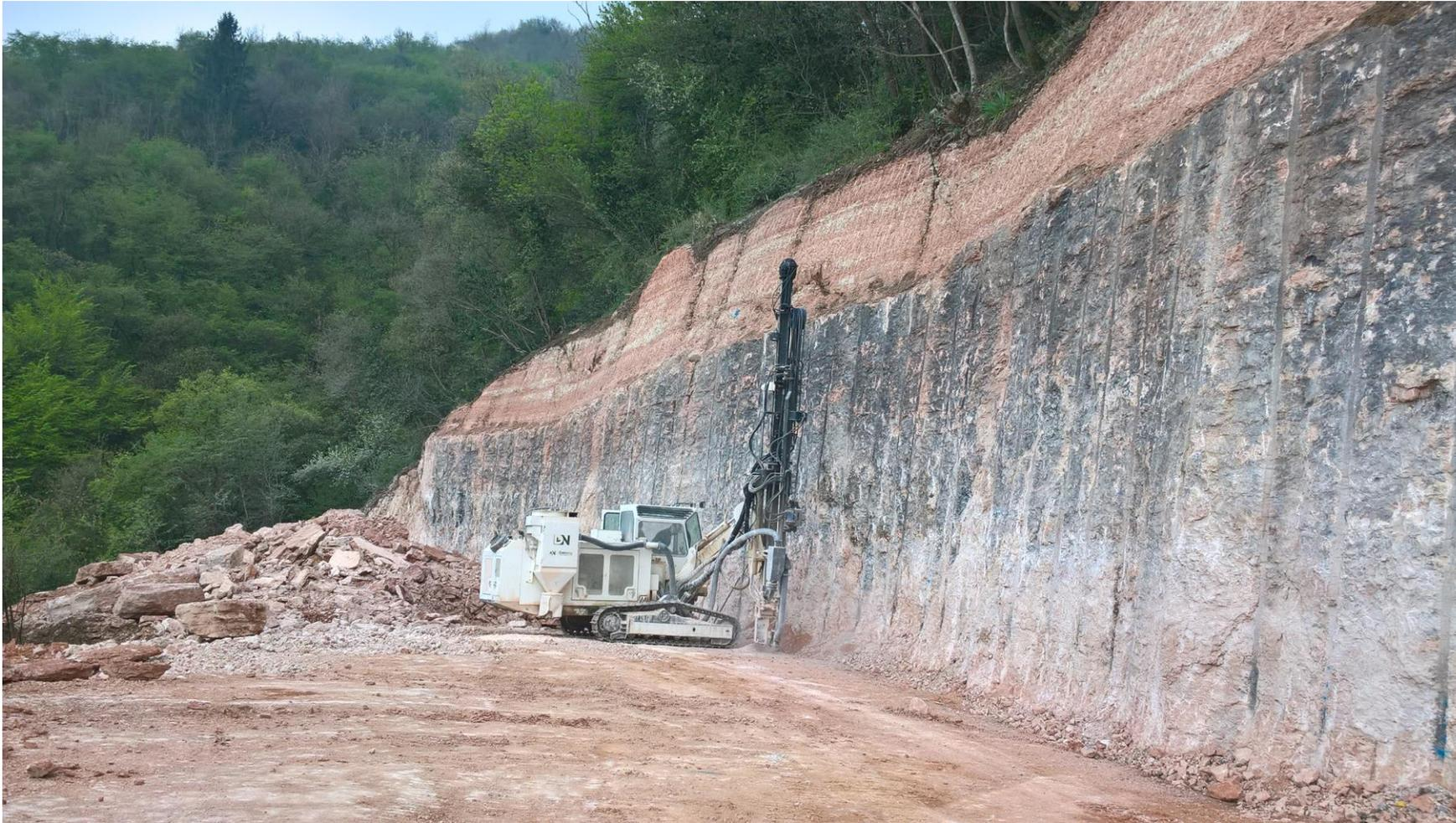
**Nella riuscita di un buon taglio con la miccia detonate, la perforazione è fondamentale, se curata e precisa restituisce risultati eccellenti**
